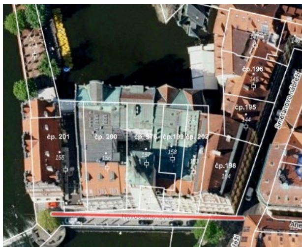
Obr. 37, Budovy ČSVTS na Novotného lávce s čísly popisnými
